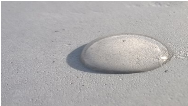
Sichtbeton mit COLORTEC® finish
