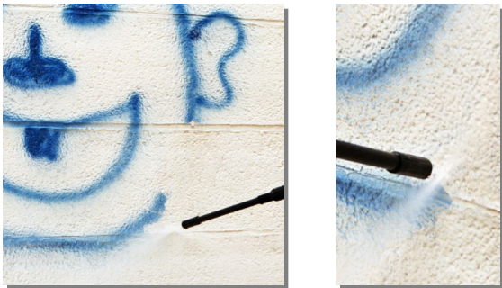
Falls geschützte Fläche mit Graffiti verschmutzt wird: Fläche mit Hochdruckreiniger reinigen
