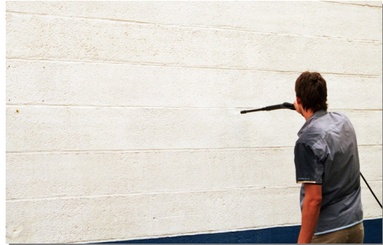
Nicht vergessen: PROWALL -Schutz auf gereinigter Fläche wieder erneuern!
