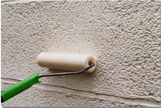
Graffitischutz PROWALL auf Wandfläche applizieren, z.B. mit Roller.
